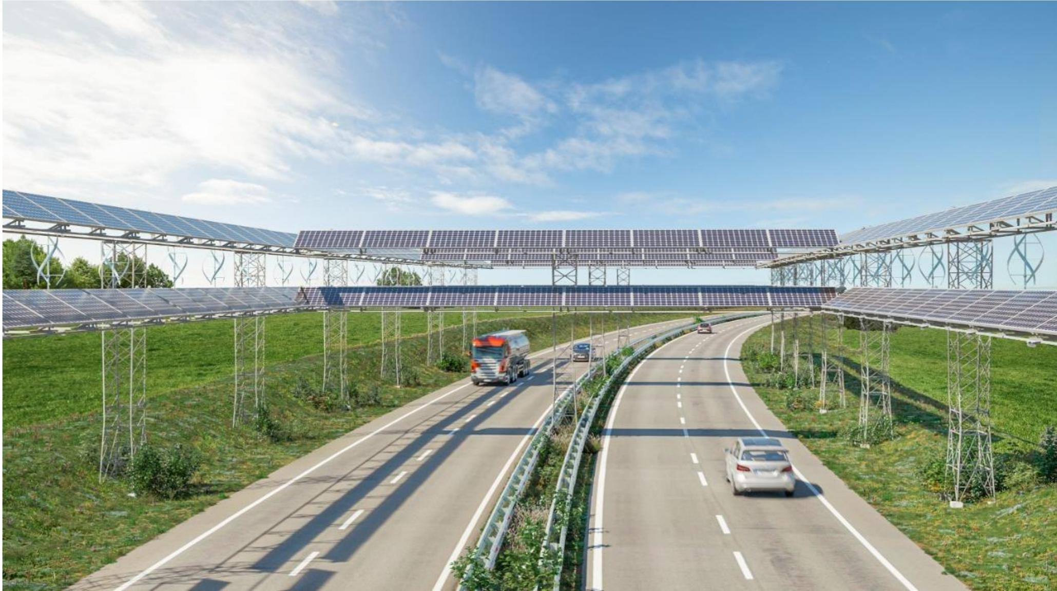
140 GWh/a von Brücken-PV-Modulen, 277 GWh/a von PV entlang der Brücken und 100 GWh/a durch Energiebänder – die 517 GWh/a entsprechen mehr als der Hälfte der Energiemenge für den Strombedarf der Frankfurter Haushalte
