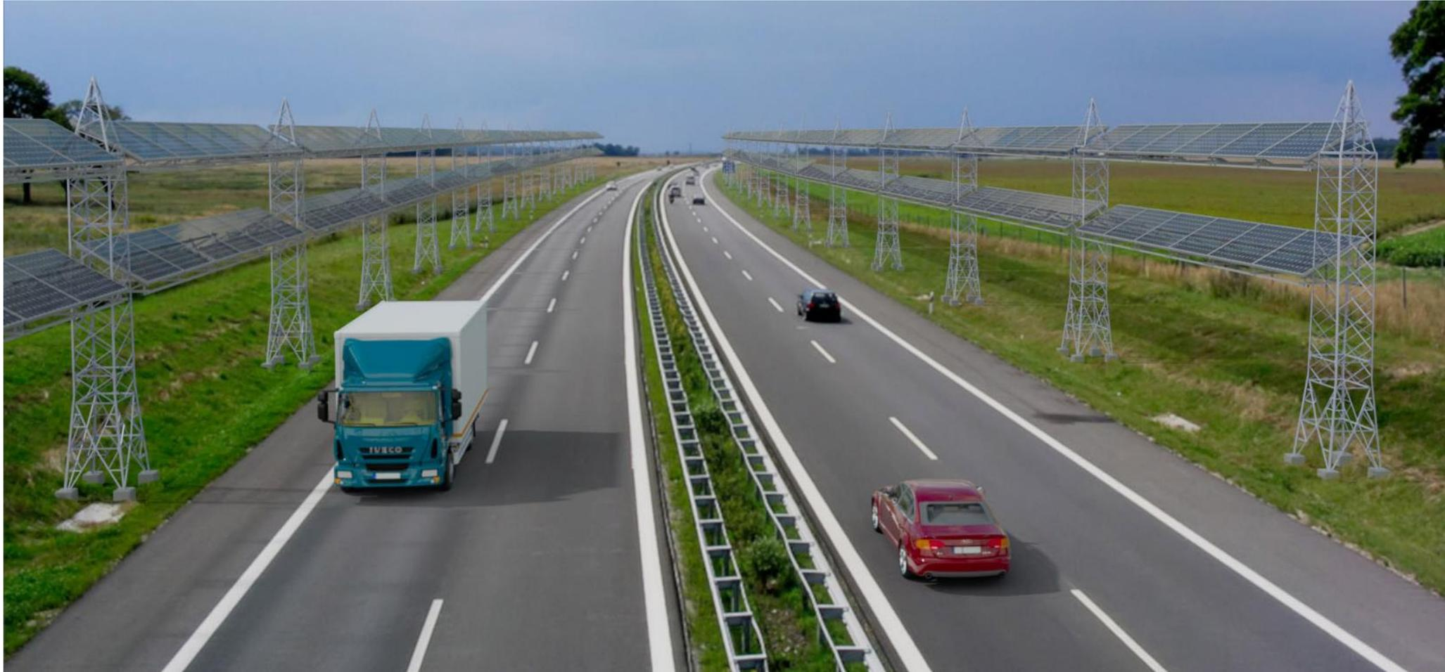
Die Stromproduktion durch PV-Module muss nicht an den Außenarmen der Brücken enden – sie kann an Masten installiert auch darüber hinaus erfolgen, entlang von Autobahnen und Bundesstraßen
